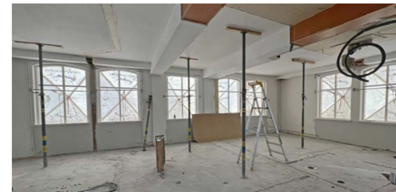
Kvarteret Vecklaren på Getingen är ett av ombyggnadsprojekten där vi fokuserar på återbruk.
